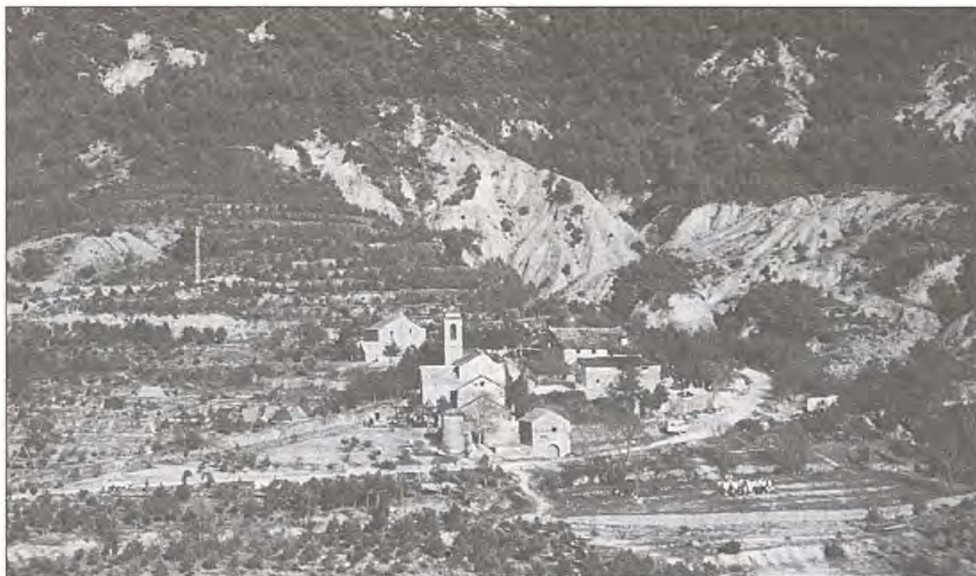
Vista general de Griébal. Primer núcleo.
