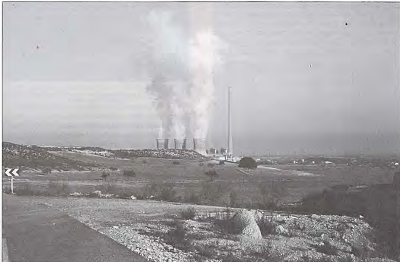
La central térmica «Teruel», en Andorra, que se alimenta con los lignitos del sector oriental de la cuenca minera turolense, en pleno funcionamiento.
