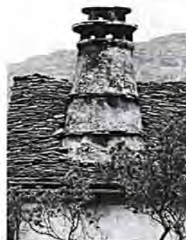
Chimenea de Allué
