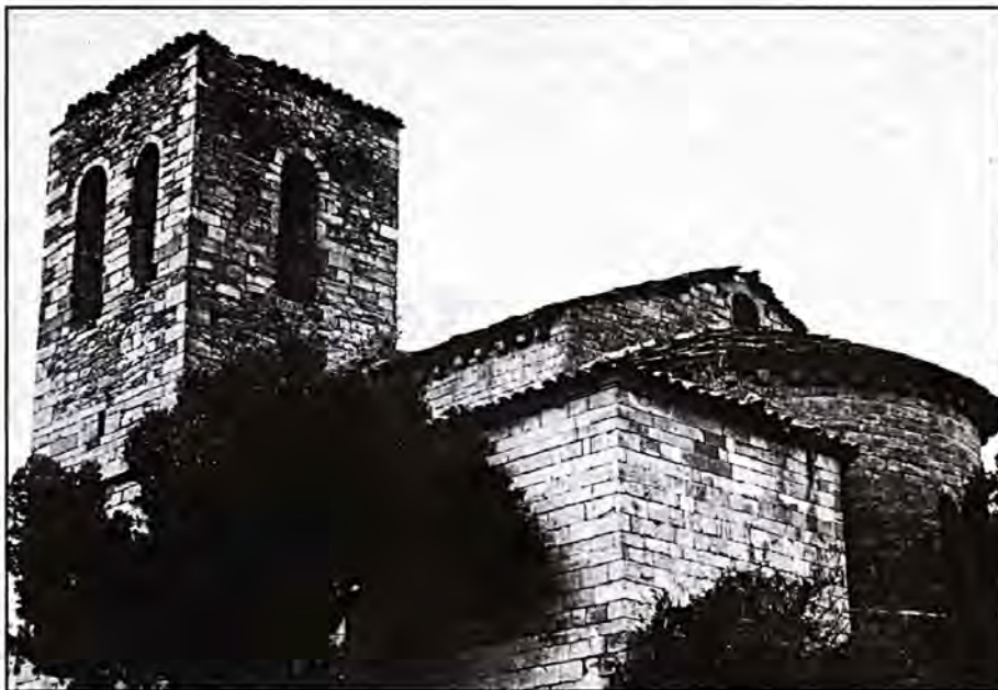
Grustán. Iglesia. Vista sur
