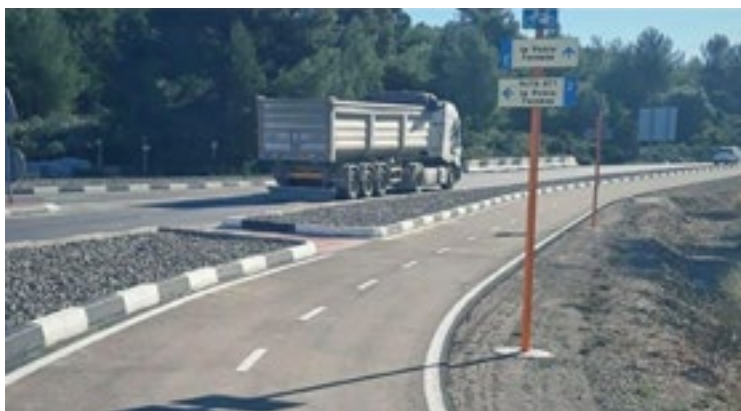
FIGURA 2. EJEMPLO DE PLATAFORMA PARA LA CIRCULACIÓN DE BICICLETAS Y/O MVP ENTRE LOS MUNICIPIOS DE VILAFAMÉS Y LA POBLA DE TORNESA (CASTELLÓN)
