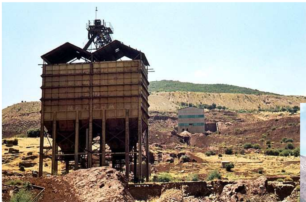
Tolvas del cargadero de mineral, Ojos Negros (© Gobierno de Aragón)
