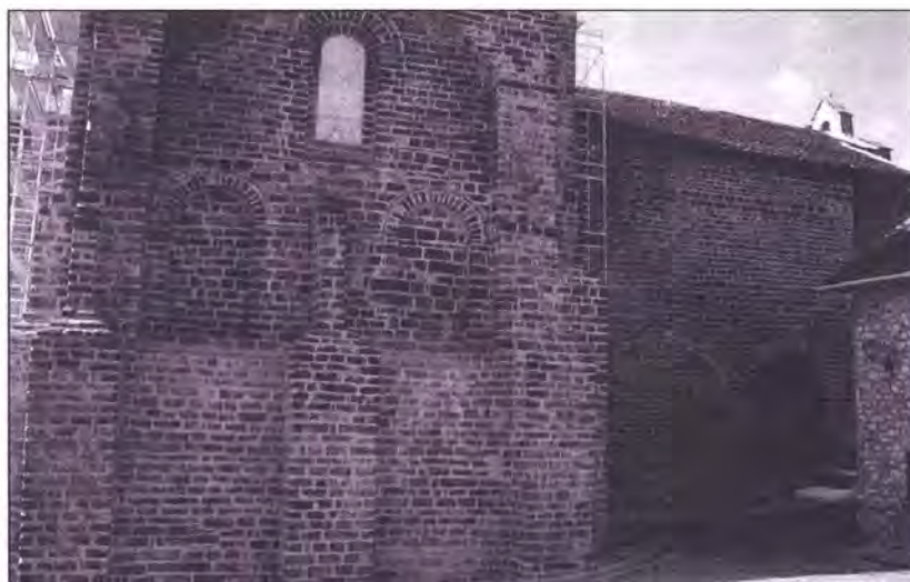
San Pedro de Siresa: una pésima restauración de los muros en 1991.
