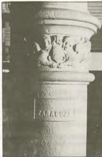
Detalle: anillo en columna de fundición.
